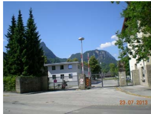
Figure 6- Vue générale de la porte du camp
